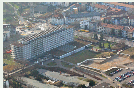
Auf dem Basler Felix-Platter-Spitalareal entstehen über 500 Genossenschaftswohnungen.
